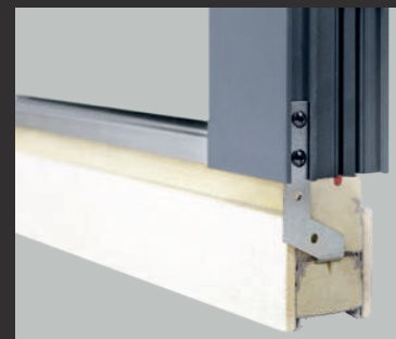
Termo-poszerzenie Stropex o wysokości 80 mm
