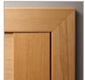
ościeżnica DIN DUO, opaski łączone pod kątem 45°
